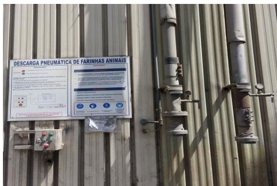
Figura 28. Descarga pneumática de farinhas animais.
