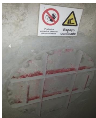
Figura 62. Entrada para o espaço confinado da base do silo.
