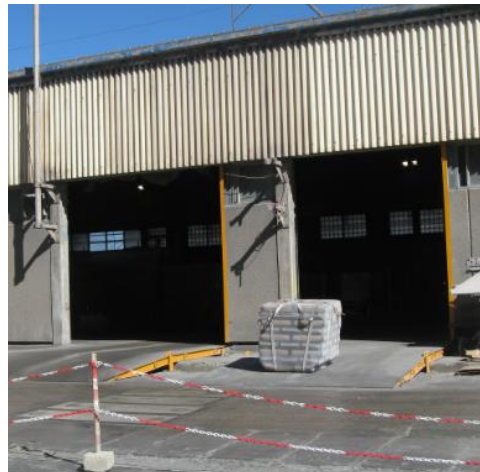
Figura 8. Barreiras físicas a delimitar o exterior do edifício do pacotão.
