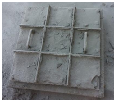
Figura 55. Entrada para o espaço confinado no topo do silo.
